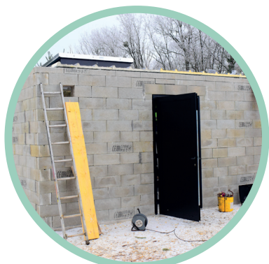
Création du bâtiment pour protéger les différentes vannes.
