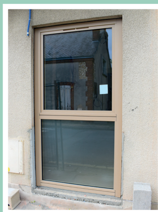
Mise en place de nouvelles fenêtres et portes sur l'ensemble du bâtiment.
