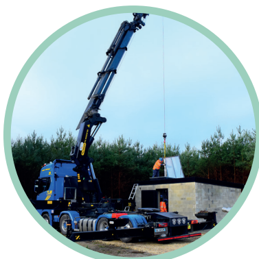
Descente de la pompe dans le forage.
