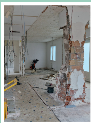
Démolition de l'ensemble des cloisons.
