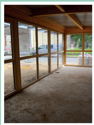
Création d'une salle d'attente dans l'ancien garage.
