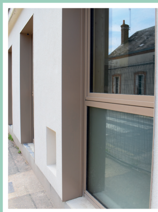
Pose d'une isolation par l'extérieur et d'un enduit de finition.
