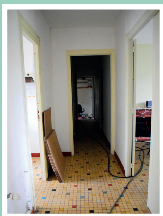
Démarrage des travaux en novembre 2025.
