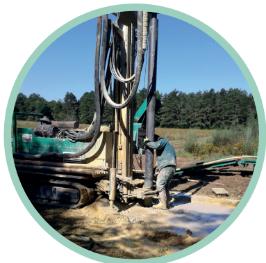
Forage de reconnaissance en 2014.
