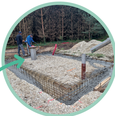
Création des fondations pour le local.
