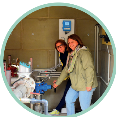
Mise en service du forage le 18 mai 2026.
